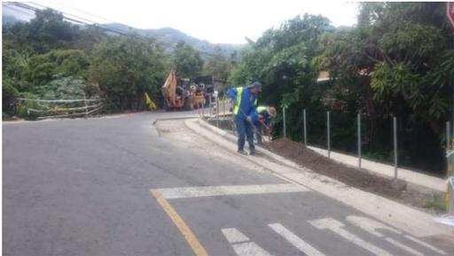
**Mejoras Alcantarilla Calle Masilla:** Se reconstruye el cordón y caño para así quede definida la calle, se coloca una baranda de protección, además se reconstruye el alerón del cabezal aguas arriba y se recupera la superficie de ruedo.
