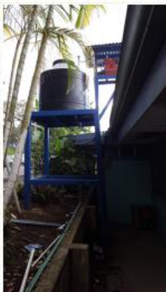
REUBICACION DE TANQUE DE AGUA CON BOMBA
