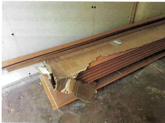
Material para el cielorraso del cuarto
