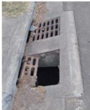
Tapas de alcantarilla dañada
