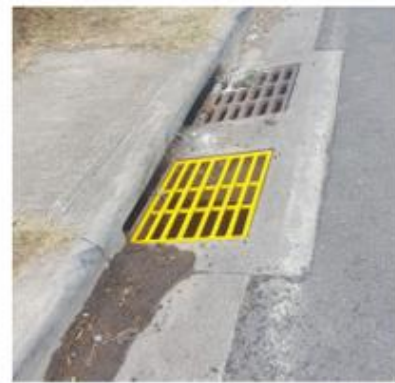
Tapas de alcantarilla dañada
