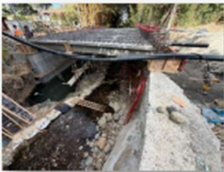
Puente Vehicular Rio Agres RN 105, 80 % de ejecución
