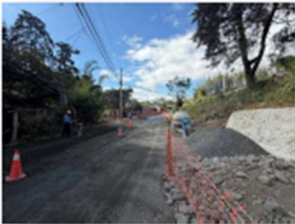
Alcantarilla de Cuadro El Curio, 90 % ejecución
