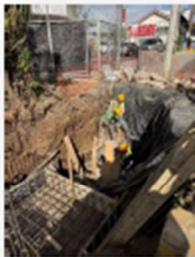
Avance fundaciones Puente Peatonal RN 105 ejecución 70%
