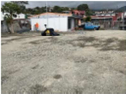
Muro de Gaviones y Nivelación de terreno Salón Comunal Zarate, 95 % ejecución.
