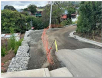
Muro Calle Los Muta 100% Ejecución
