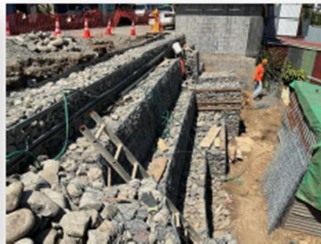
Ilustración 7 Estabilización Calle Los Mangos, Avance 95 %
