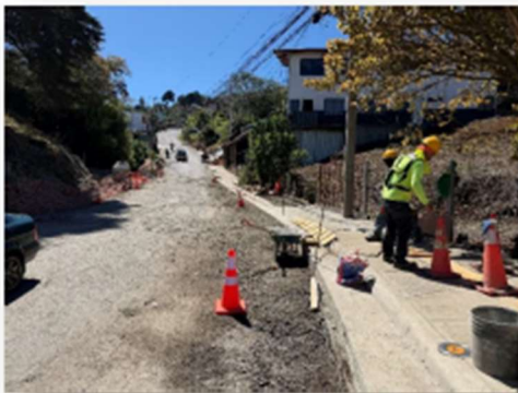
Ilustración 6 Alcantarilla Huacos, Avance 95 %
