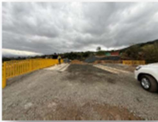
Ilustración 3 Paso de alcantarilla Lechones (Plantel) Avance 100%
