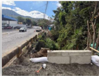
Ilustración 4 Puente Peatonal RN 105 Avance 85%
