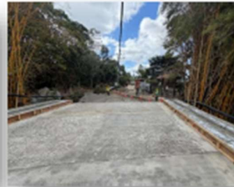
Ilustración 5 Puente Vehicular RN 105, Avance 90%
