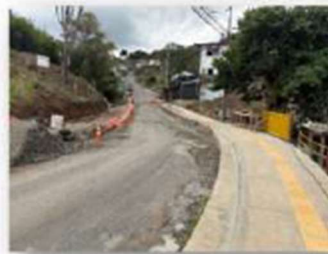
Alcantarilla y obras adicionales Calle Curio
