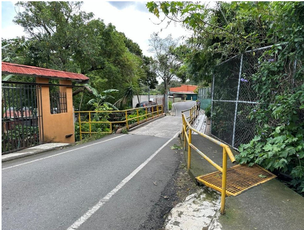
Puente Santa Teresa
